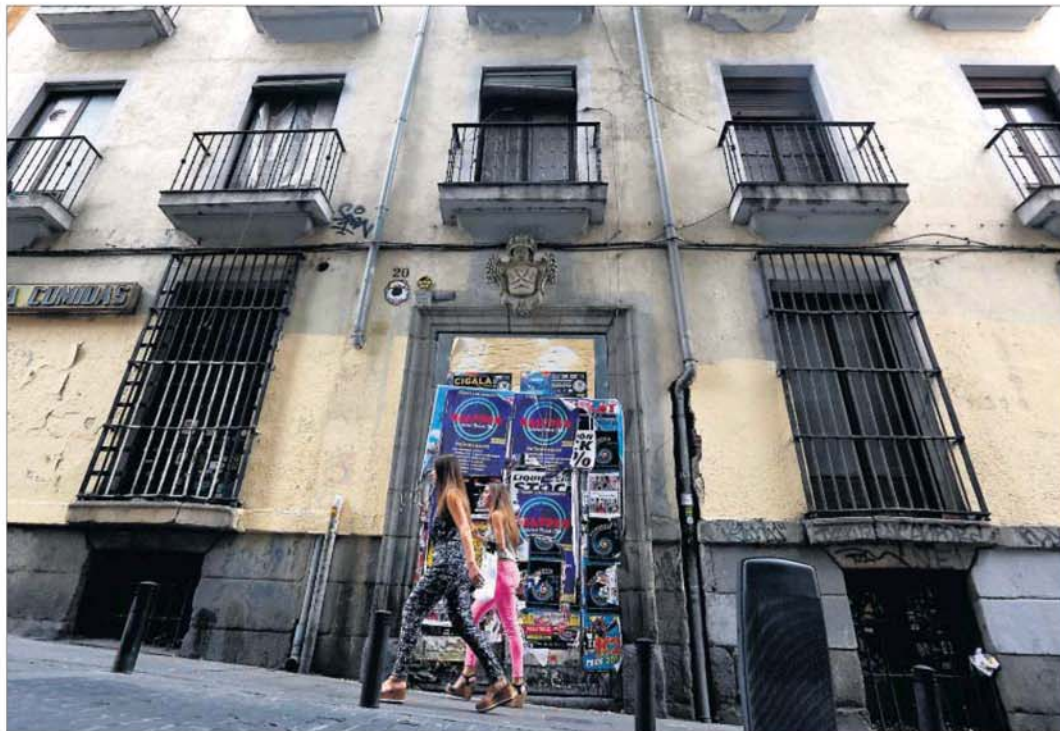
Estado de abandono del inmueble, con la cruz de la Orden de Malta sobre el pórtico de entrada. / CARLOS ROSILLO
