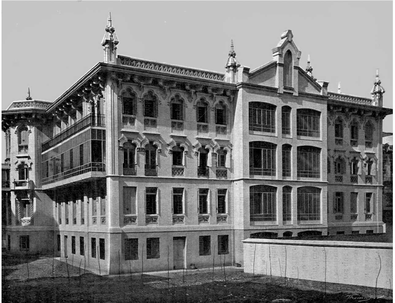
Fachada trasera al jardín del Colegio de las Damas Catequistas, donde se ve el piso de semisótano rebajado bajo la rasante de la calle que servía de basamento al conjunto. Otros elementos a destacar son el cuerpo ochavado resaltado al sur, que daba réplica al de la entrada principal, y la galería acristalada volada del primer piso. Fotografía: Casa Moreno. Archivo de Arte Español (1893-1953), IPCE, Ministerio de Educación, Cultura y Deporte.
