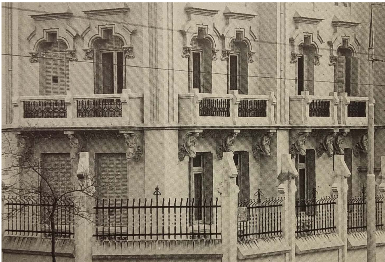
Detalle de la fachada del Colegio de las Damas Catequistas donde se aprecian las originales ménsulas que soportan los balcones del primer piso, en forma de ángeles orantes arrodillados. Casa Moreno. Archivo de Arte Español (1893-1953), IPCE, Ministerio de Educación, Cultura y Deporte.
