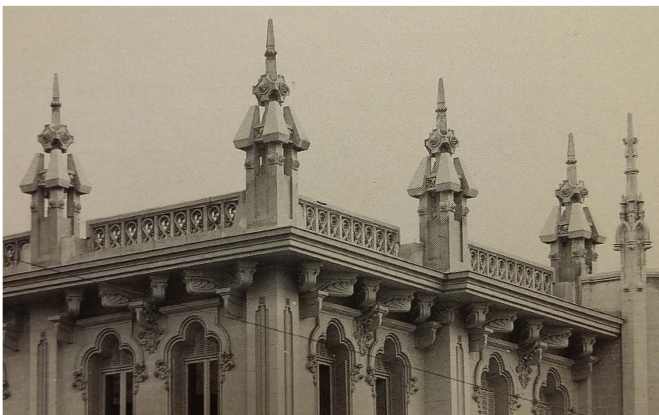
Detalle de la fachada del Colegio de las Damas Catequistas donde se aprecian las originales ménsulas dobles angulares que soportan los cornisa de remate y los extravagantes pináculos de coronación. Casa Moreno. Archivo de Arte Español (1893-1953), IPCE, Ministerio de Educación, Cultura y Deporte.
