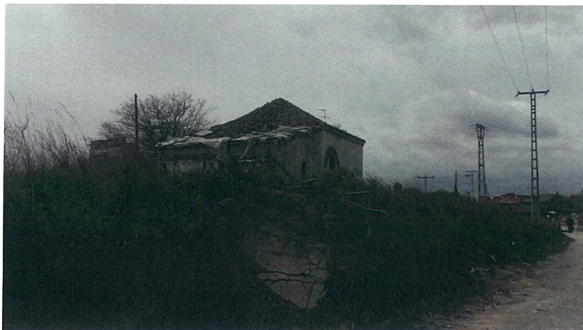
FIGURA 7. VISTA HACIA FACHADA ESTE
