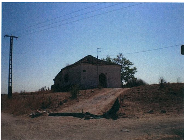
FIGURA 5. VISTA HACIA FACHADA OESTE
