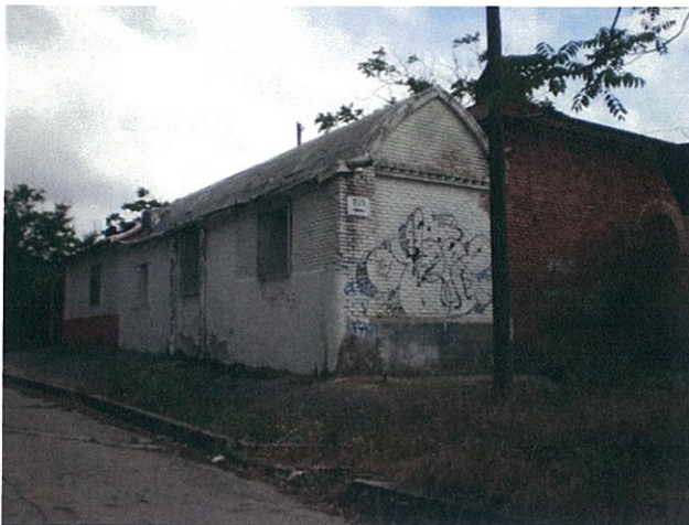
FIGURA 10. VISTA HACIA FACHADA NORTE
