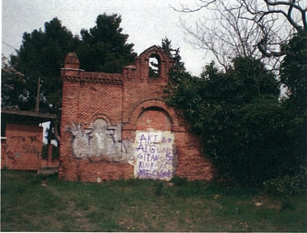
FIGURA 8. VISTA HACIA FACHADA SUR
