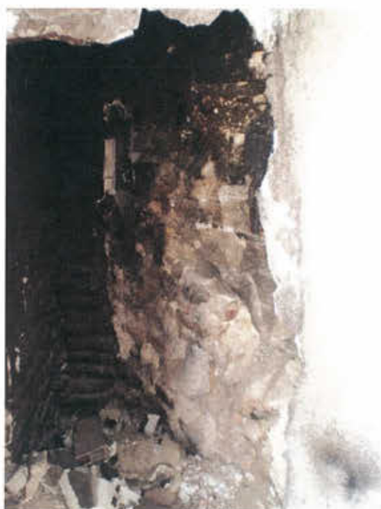
MURO DE ERMITA HACIA EL EXTERIOR
