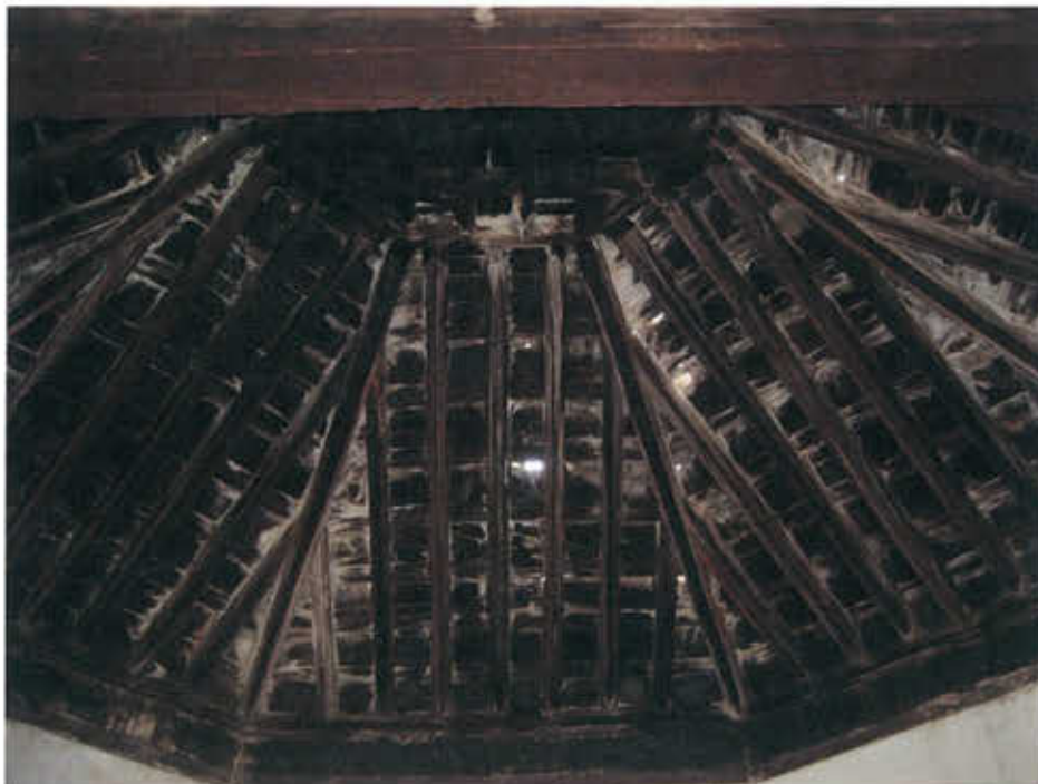
Figura 30: Ermita de San Roque. Detalle de la armadura interior.
