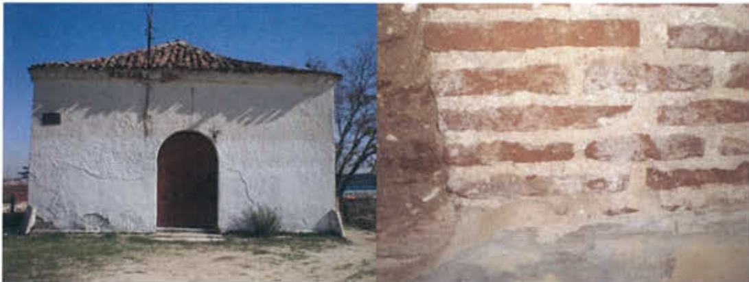
MURO DE FACHADA PRINCIPAL. OESTE
