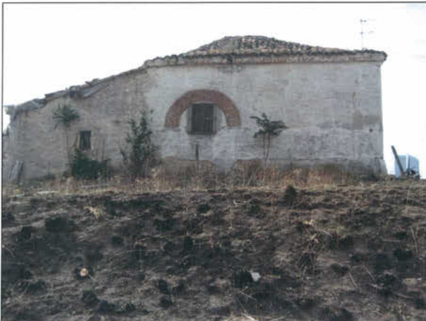
Figura 25: Ermita de San Roque. Fachada Norte
