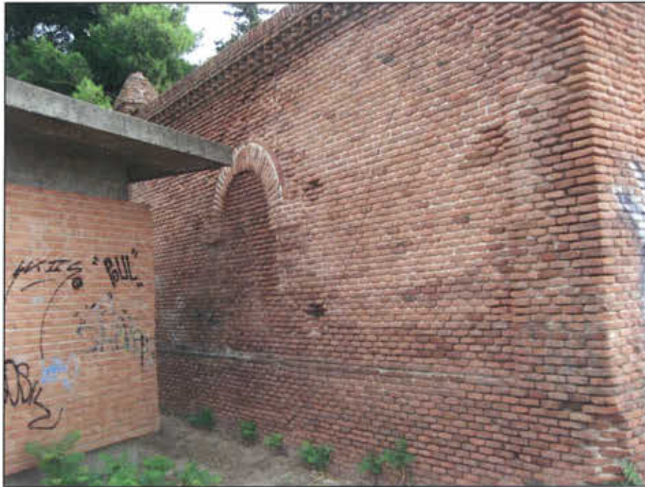
Figura 20 Ermita de Ntra. Sra. de Lourdes. Fachada Este y edificio del canal de Isabel II.
