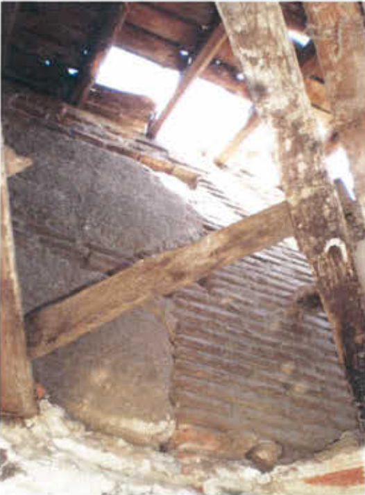
ESTRUCTURA DE CUBIERTA
