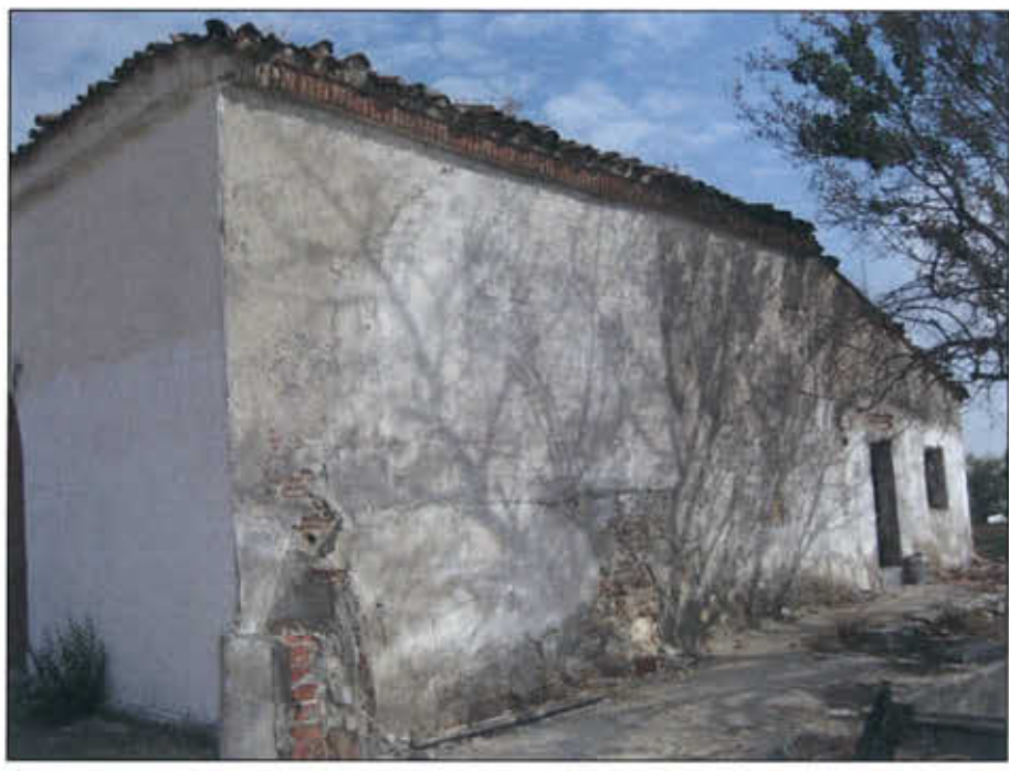
Figura 26: Ermita de San Roque. Fachada Sur. Al fondo vivienda adosada
