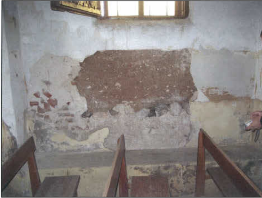
Figura 34: Ermita de San Roque. Interior en donde se aprecia la fábrica de tapial.
