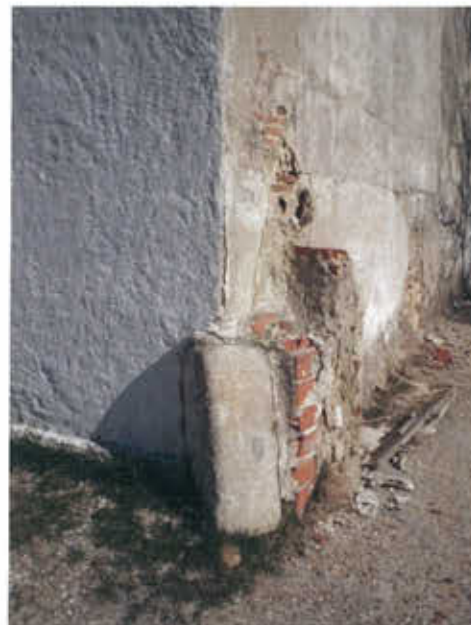
SILLAR EN ESQUINA
