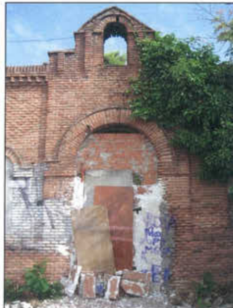
Figura 19 Ermita de Ntra. Sra. de Lourdes, detalle del acceso cegado.
