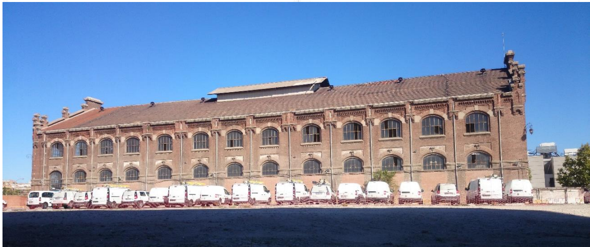
Nave principal de la Sociedad de Gasificación Industrial. Foto del autor, octubre de 2017.
