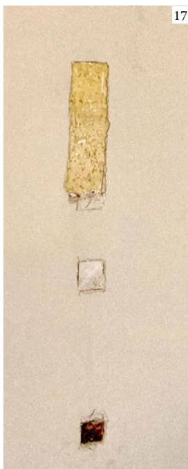
Figura 17: Las calas estratigráficas efectuadas en los paramentos de la escalera del chaflán muestran la decoración original con estucos rojos y ocres
