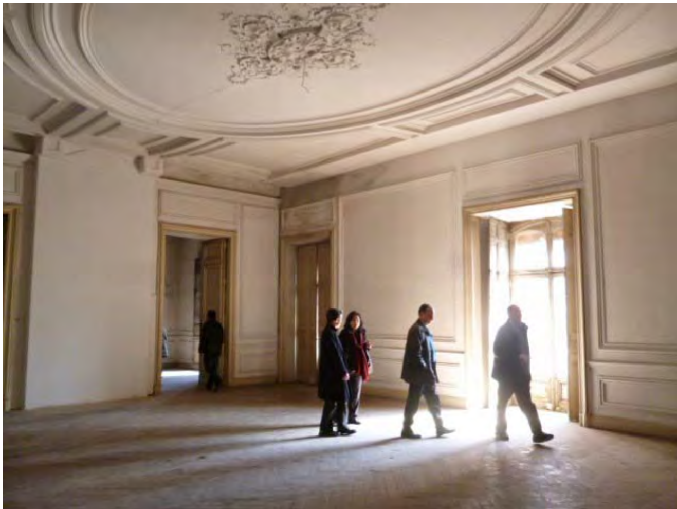
Fig. Fig. 6- Salón principal del palacio. A la izquierda puede verse el tiro de chimenea cegado con un tabique moderno. Foto: IU –San Blas Canillejas
