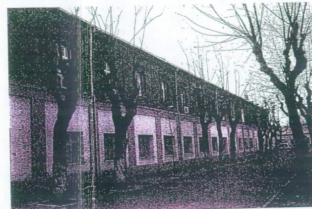
FACHADA INTERIOR, EXTREMO SUR
