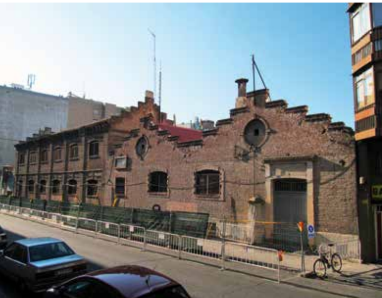
Talleres de Metro en Pacífico, de 1923. Foto Álvaro Valdés.
