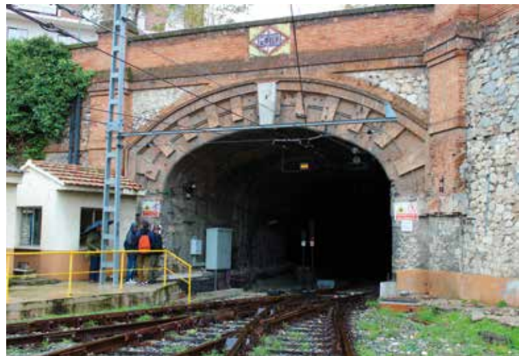
Embocadura del túnel de la línea 2 actualmente en las cocheras de Ventas. Foto Antonio Manuel Sanz.
