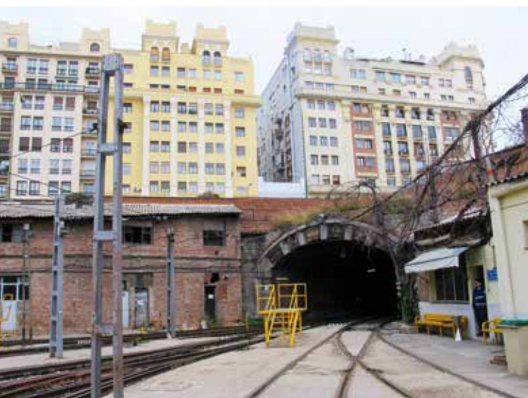
Vista de la embocadura del túnel diseñada por Antonio Palacios, con los edificios Titanic al fondo. Foto Álvaro Bonet.
