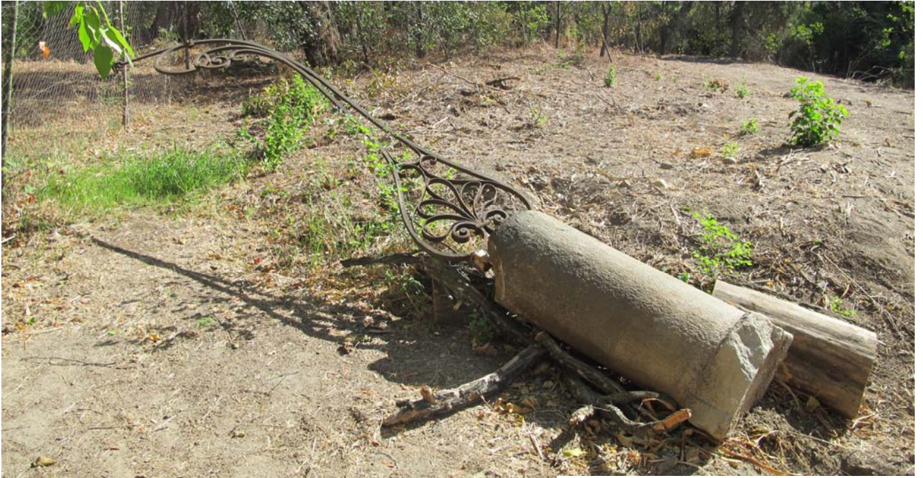
Vista de una farola histórica derribada en la Quinta de Torre Arias, tal como estaba en septiembre de 2014. Foto: VPAT.
