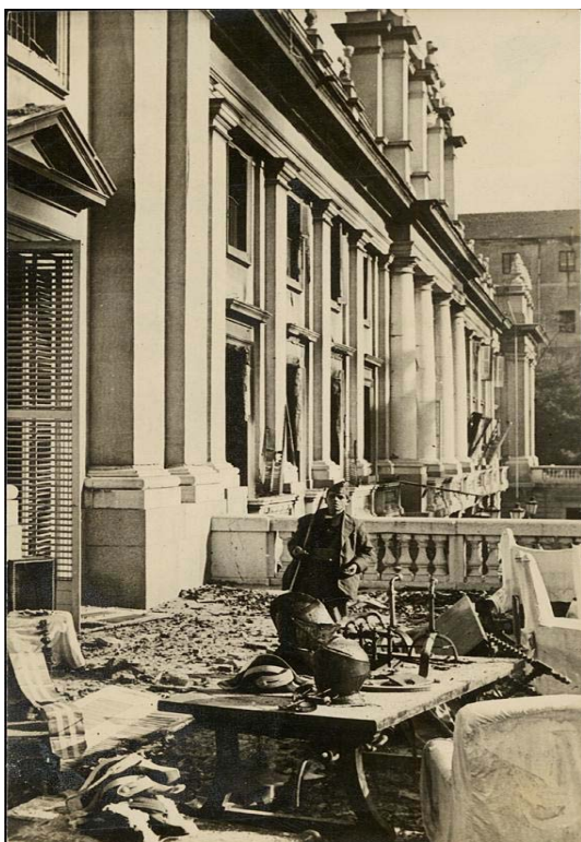
Fig. 220- Anónimo: Fachada del palacio de Liria después del incendio , 1936. Archivo Vaamonde. IPCE, Ministerio de Educación, Cultura y Deporte.
