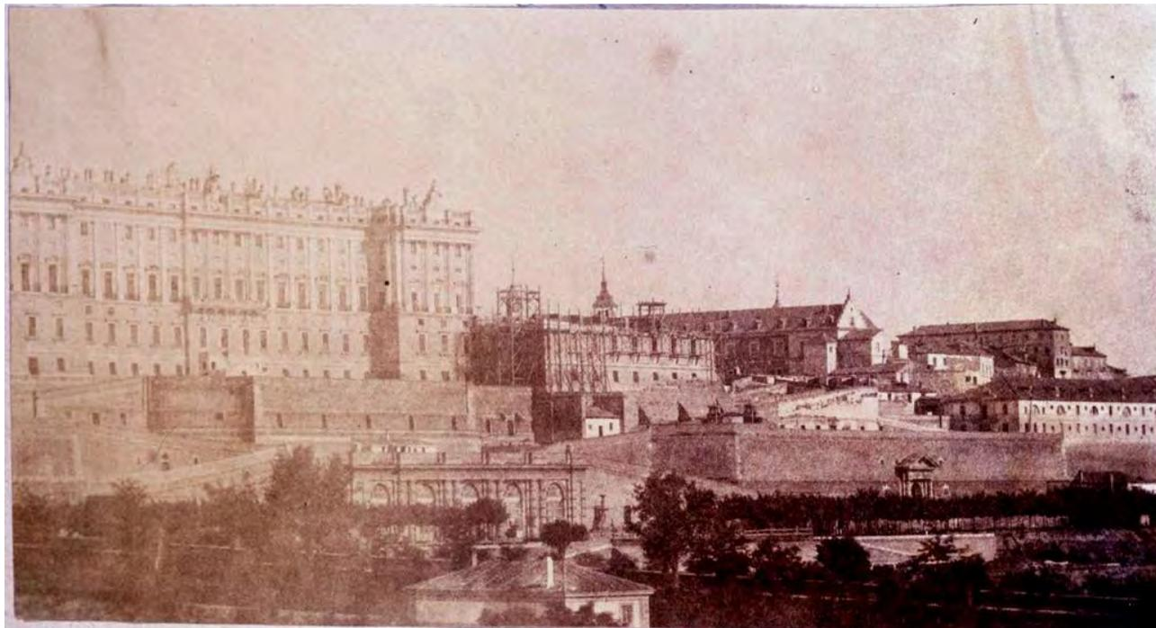
Fig. 41- Fotografía anónima de hacia 1860 en la que pueden verse los andamios instalados para terminar de construir el basamento de la ampliación sudoccidental proyectada por Sabatini.
