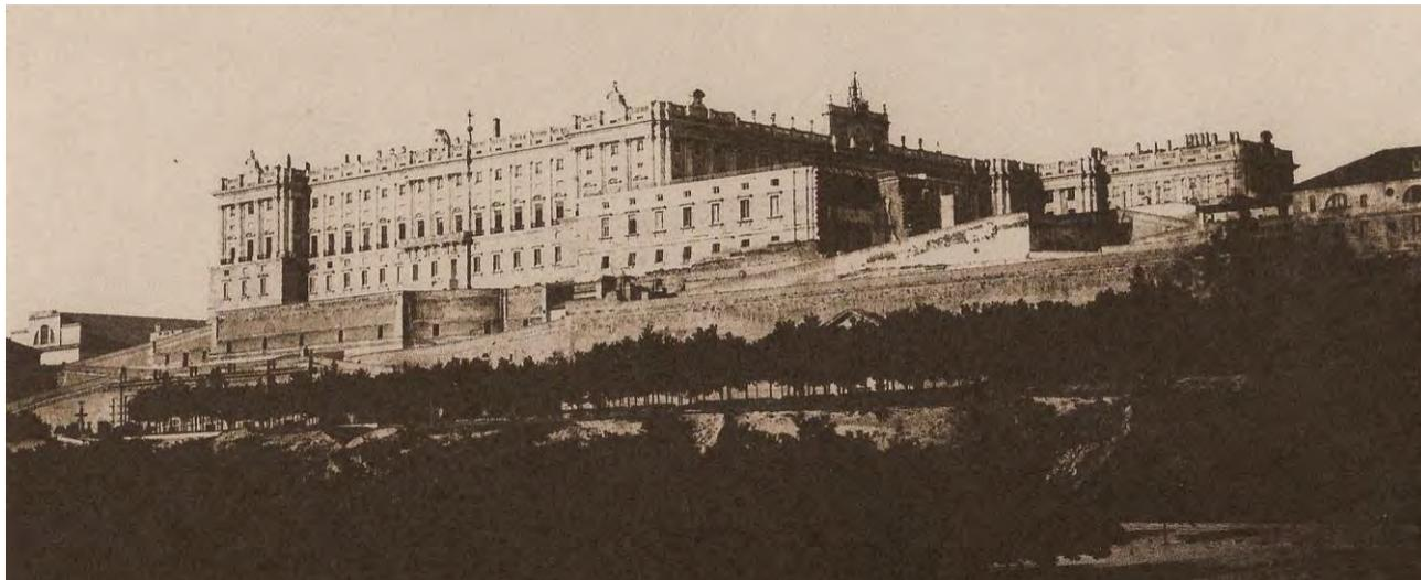
Fig. 14- Un calotipo de Louis de Clerq fechado hacia 1859 permite apreciar el inacabado cuerpo sudoccidental del palacio proyectado por Sabatini, que señalará el diseño a seguir para terminar el borde occidental de la plaza de la Armería.
