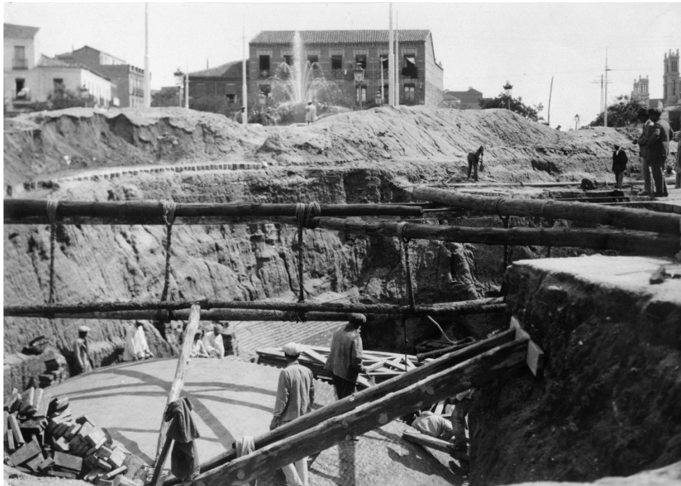
Construcción del túnel de Cocheras en la Glorieta de Ruiz Jiménez. 1917. Archivo Histórico de Metro.
