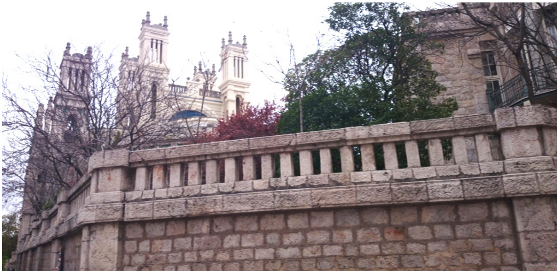
Muro perimetral del Hospital de Maudes, realizado pocos años antes por Palacios. Foto MCyP, 2016.
