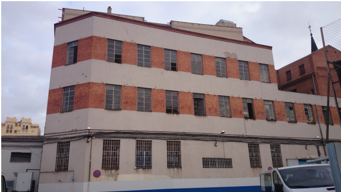
El edificio de almacenes en la actualidad (diciembre 2015). Foto MCyP.
