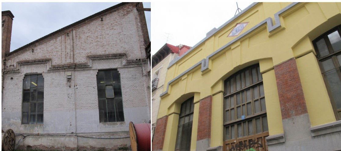
Izda: Nave central de fábrica en las Cocheras en 2015. Foto MCyP. Dcha: Subestación de Quevedo en la calle Olid en 2015. Foto MCyP.
