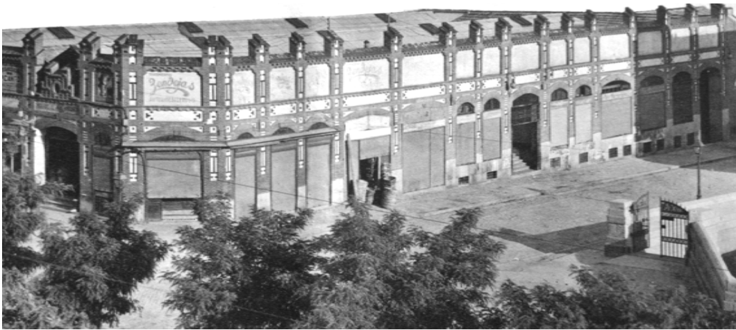
Acceso original a Cocheras por el chaflán, frente al mercado de San Antonio, 1920. Colección particular.
