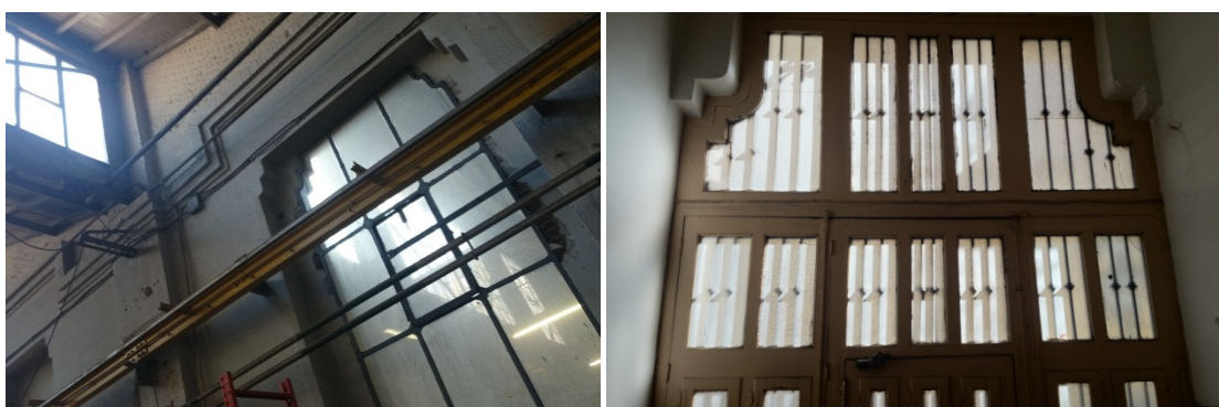
Detalle de los vanos de Cocheras y las Subestación de Salamanca, en 2016. Foto MCyP.
