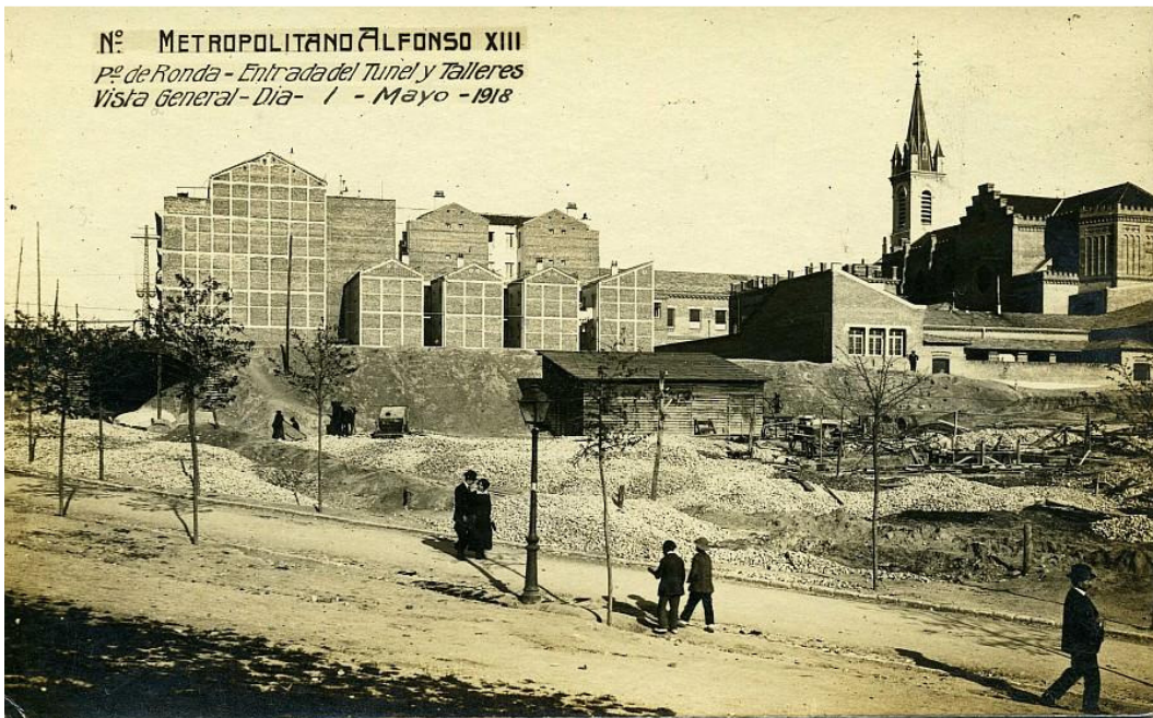
Obras de construcción de las Cocheras (01/05/1918), con el Camino de Aceiteros en primer término. Contra el terraplén se aprecia el Taller de Herrería licitado por Palacios como casilla de obras. Museo de Historia de Madrid. Inv. 2007/17/2
