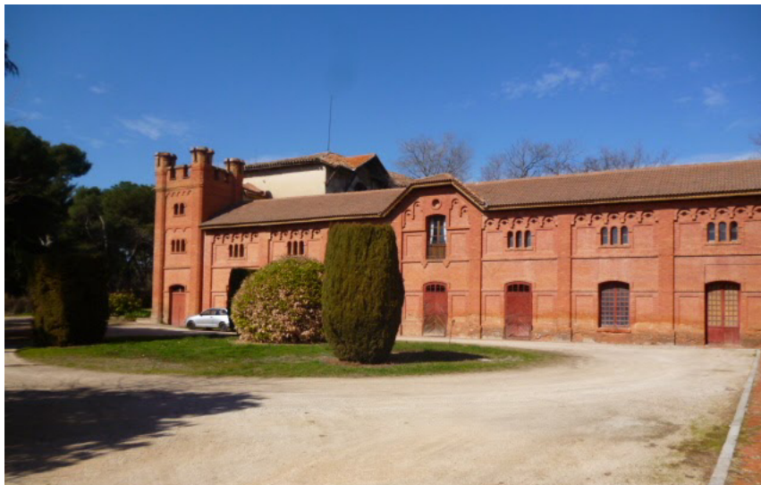
Fig. 43- Fachada exterior meridional de las caballerizas. Foto IU –San Blas
