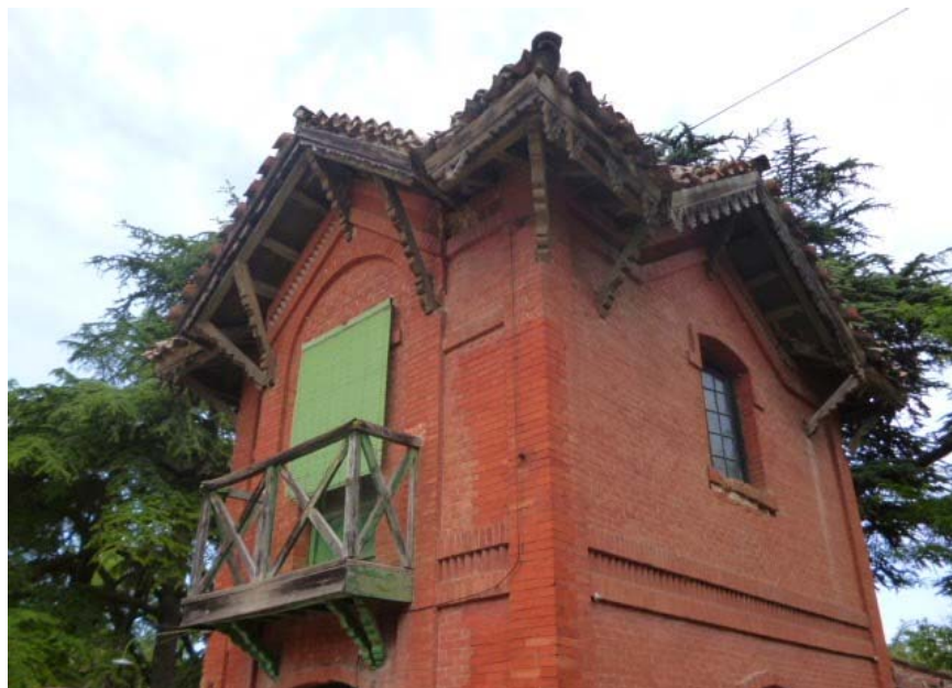
Fig. 35- Caseta de la entrada. Foto IU –San Blas Canillejas
