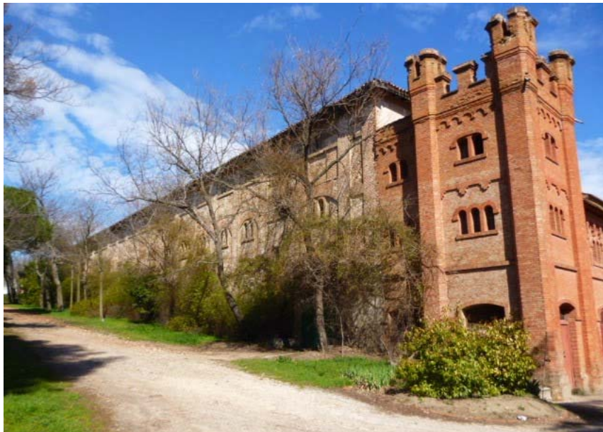
Fig. 42- Fachada exterior occidental de las caballerizas. Foto IU –San Blas
