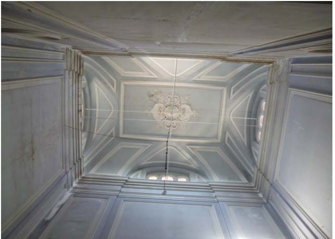
Fig. 50- Caja de la escalera principal del palacio. Foto IU –San Blas Canillejas
