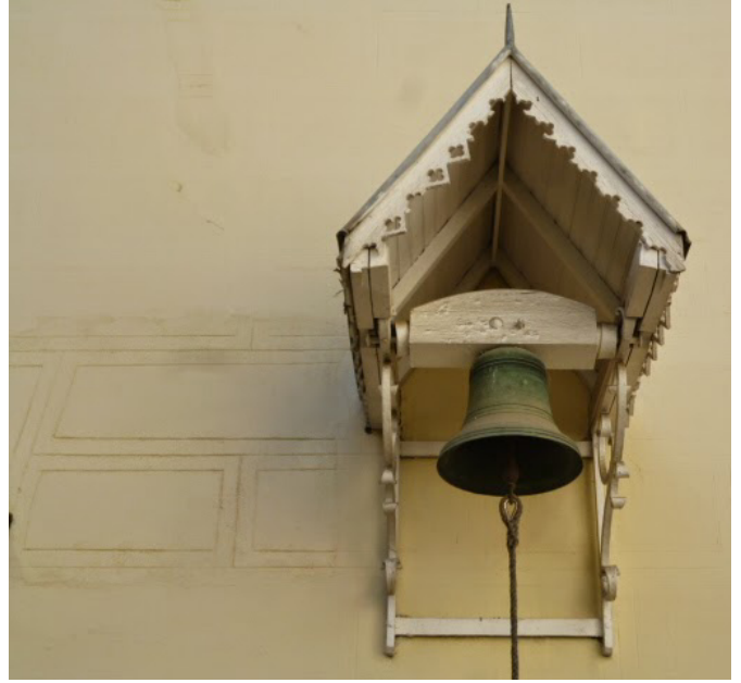
Fig. 56- Detalle de una campana del palacio. Foto IU – San Blas Canillejas
