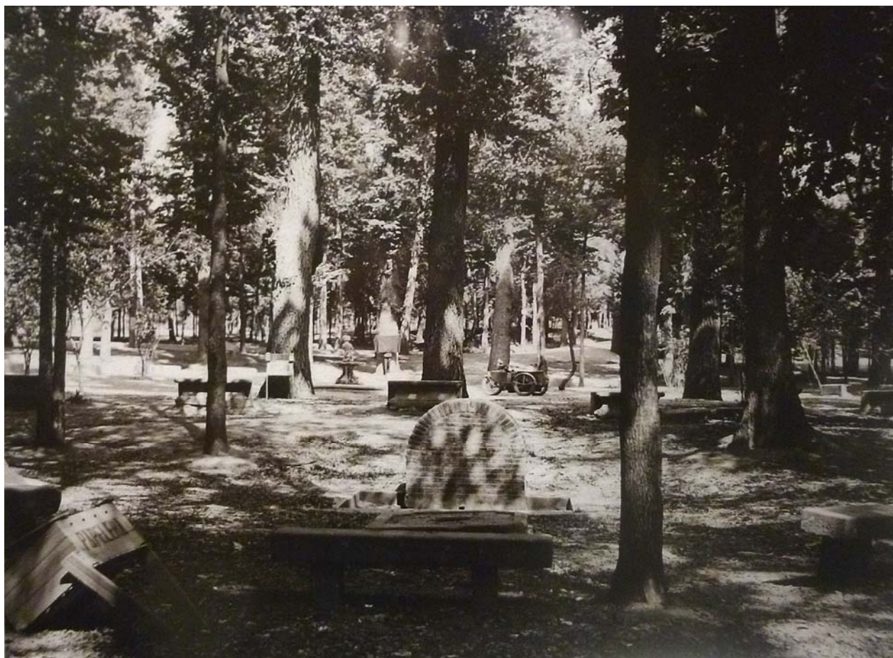
Fig. 58- Fotografía de la Glorieta del Príncipe en el momento de ser demolida en 1933. Al fondo todavía se distingue la “Fuente del Pequeño Tritón”. Hemeroteca Municipal.
