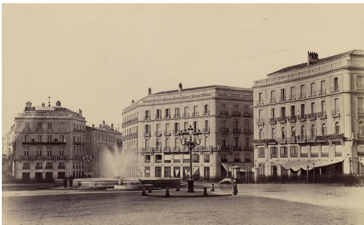
Fig. 69- La fuente de la Puerta del Sol tras ser reformada con la instalación de un segundo rebosadero en forma de venera que vierte a un nuevo piloncillo en el costado oriental, similar en todo al existente en el lado opuesto.
