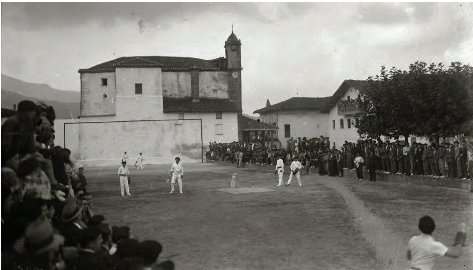
1931 Zubieta, plaza de juego de pelota, jugando a rebote. Imagen Pascual Marin. Kutxa fototeka. La pared de rebote aumentada adosada a la pared de la iglesia de Santiago.
