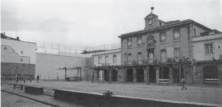
1997 Amasa Villabona. Frontón adosado al rebote, que es el alzado lateral de las viviendas.
