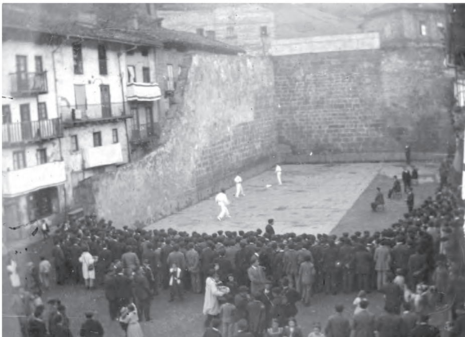
1920 Ermua. Indalecio Ojanguren. Archivo de la diputación foral de Gipuzkoa. Partido en las fiestas de Santiago. La pared original es de la anchura de la plaza entre 15 y 20 metros, el juego a blé solo precisa 10 metros de ancho. El alzado de la pared izquierda oculta las vistas de las viviendas a la plaza.
