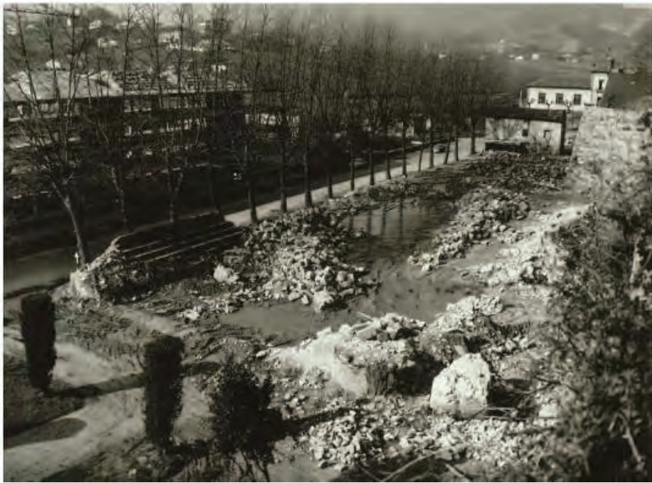
Imagen del derribo del frontón. A.M.Hondarribia. Imagen incluida en el Documento U-41-4.1001
