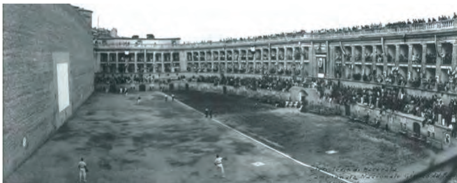
1829 Giuoco del pallone col bracciale en el Sferisterio de Maceratta.
