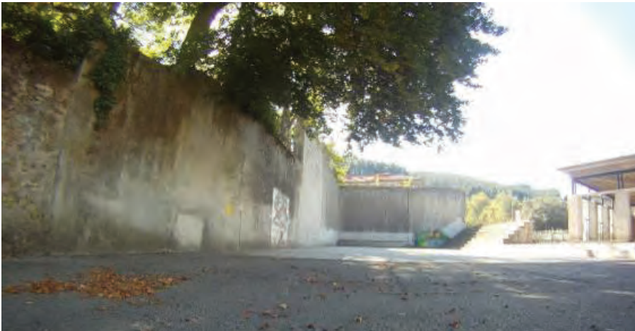
Imagen: Plaza de Oñati. 2014. Foto: Daniel Carballo. Se observa la pared de rebote prolongada con un muro de menor calidad que la construcción original.
