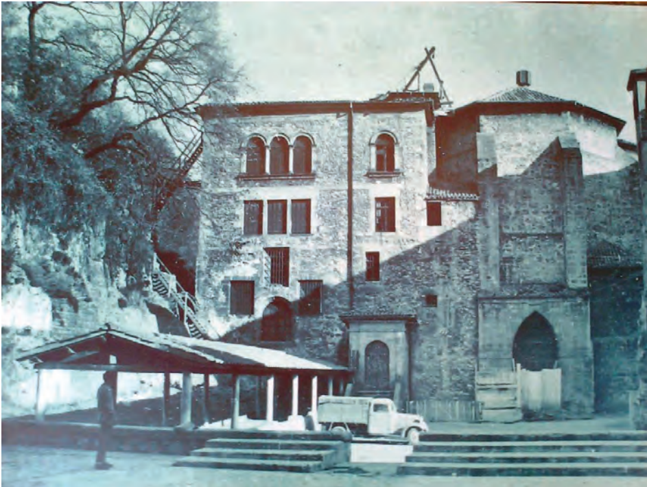
1955-1956. Construcción de cubierta para el bolatoki, junto al frontón de la calle 31 de Agosto, adjudicada a Construcciones Usarraga. (Archivo Municipal de Donostia D-10-11-01).
