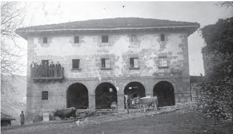
1914 Orexa. Indalecio Ojanguren. Archivo Diputación foral de Gipuzkoa. Bajo el balcón el botarri.
