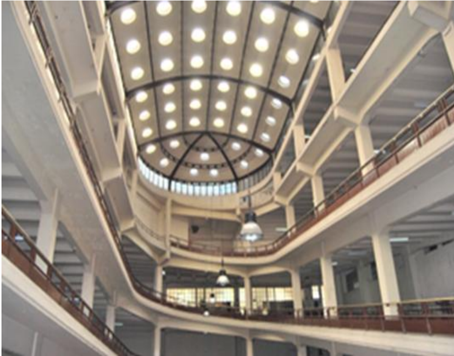
Rampa y Bóveda del Edificio de Aparcamiento
