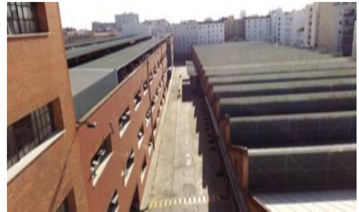
Calle interior entre los Edificios de Aparcamiento y Talleres
